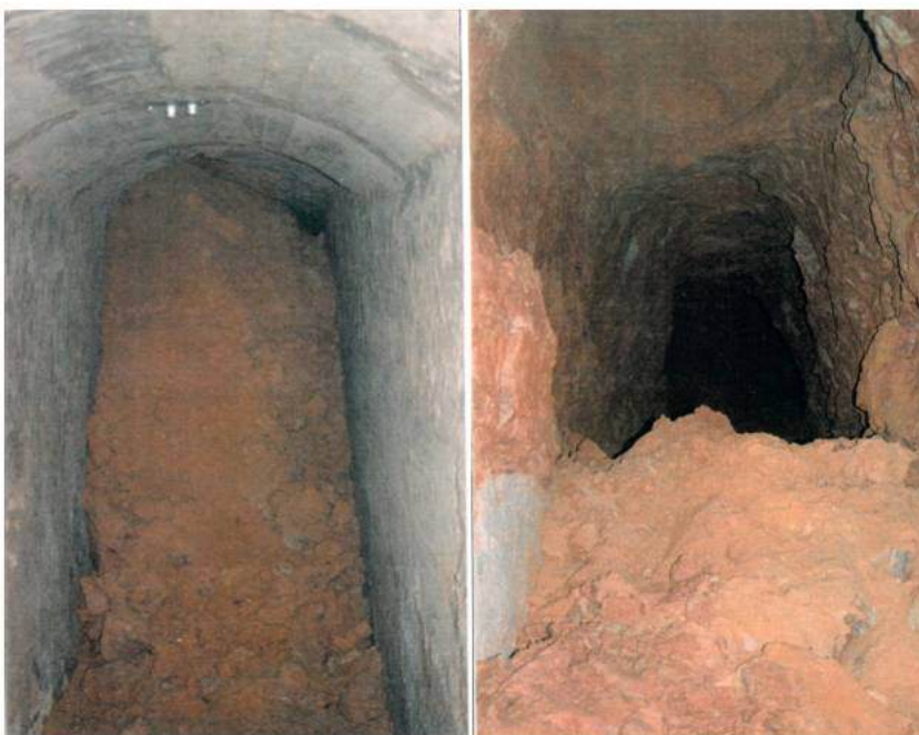
Fotografías de la galería principal y ramal de los refugios de la guerra civil hallados en Ceste. Memoria del proyecto de consolidación y restauración de los refugios de la guerra civil en Ceste (Valencia).
